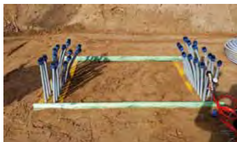
Jede einzelne Lage wurde separat abgedrückt und protokolliert
