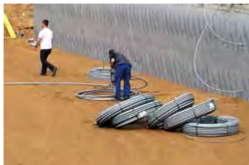
Für den Erdspeicher wurden unter der Bodenplatte 4 000 m PE-Rohre in Schichten eingebracht
