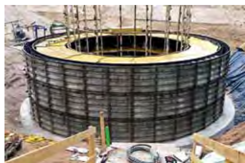
Für den Eisspeicher wurde ein Betonkörper mit einem Volumen von 172 m 3 im Erdreich versenkt
