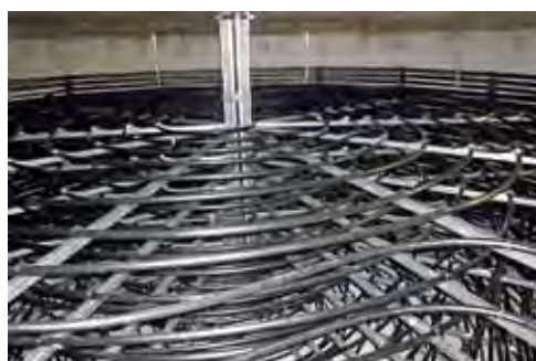
Mit Eis heizen und kühlen nutzt die Energie, die beim Aggregatswechsel von Wasser entsteht
