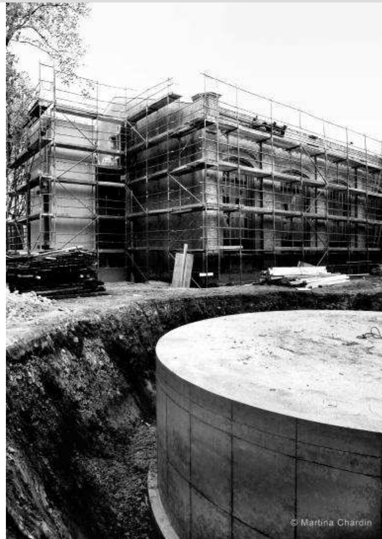
Der Eisspeicher der Pumpstation vor dem Verfüllen
